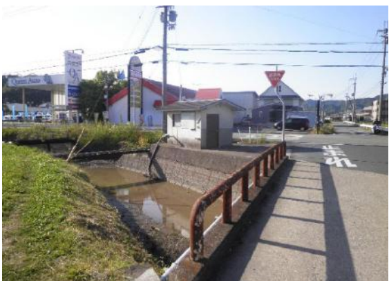
「第5揚水場」 (宇土：県道池上杉線沿い)
