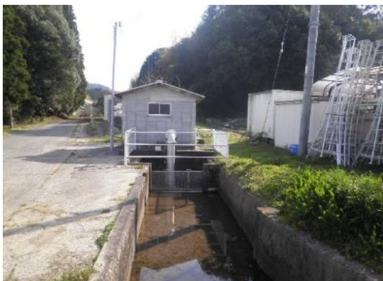
「第4揚水場」 (東吹下：青池北側)
