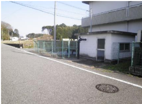
「第6揚水場」 (東吹上：赤池西側)
